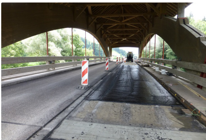
Fahrbahnsanierung der Bubeneibrücke im Emmental, Kanton Bern
