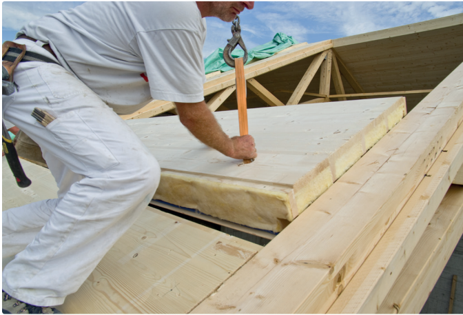
Montage von Eggo Dachelementen
