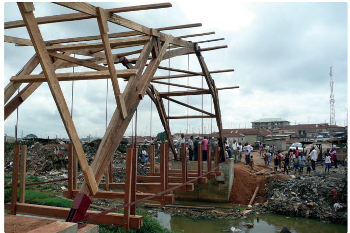
Eine der neu errichteten Brücken in Ghana
