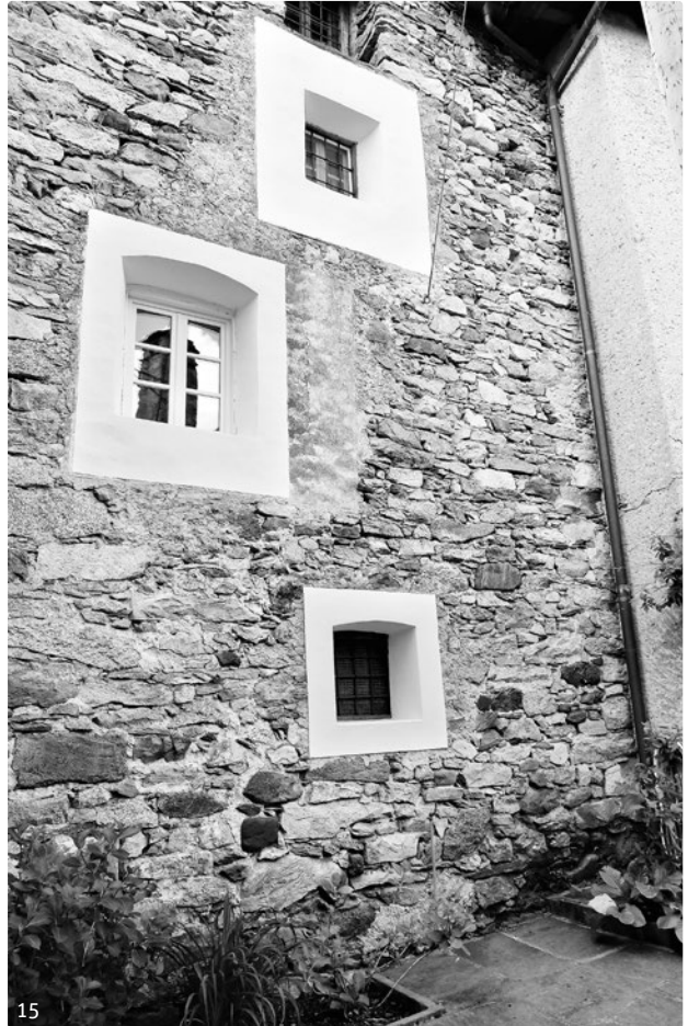
14 Typische Türöffnung mit einem Sturz aus Kastanienholz, Lionza. 15 Der Collarino dient dazu, den Materialwechsel bei der Fenstererweiterung zu verdecken.
