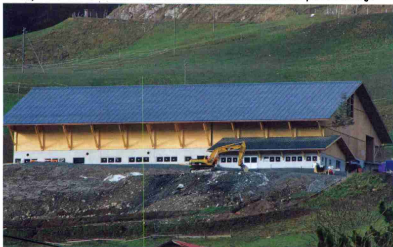
Die dachintegrierte PV-Anlage des Bauernhauses Tille in Château-d'Oex hat eine Nennleistung von 130 kWp und bedeckt etwa 1000 m 2 . Es werden über 130 000 kWh Solarstrom pro Jahr erzeugt.
