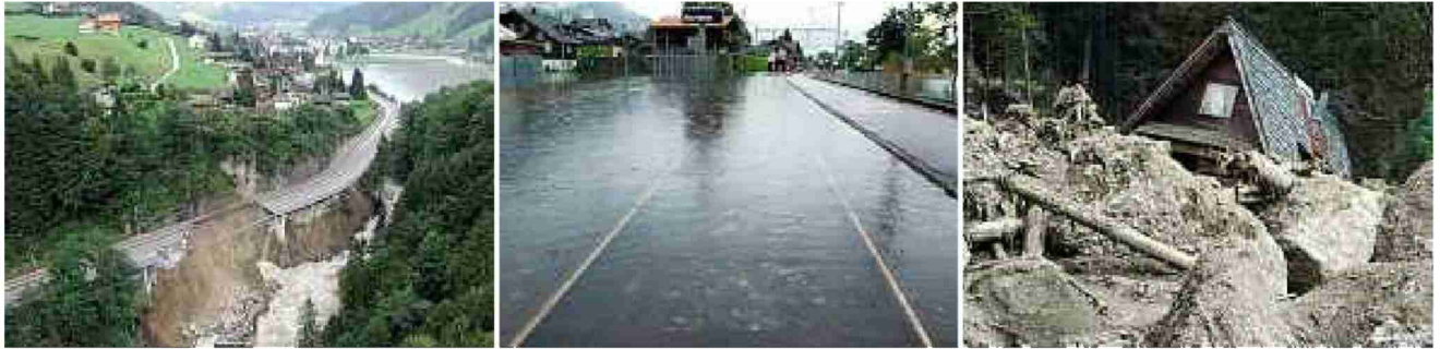
Massive Schäden an Häusern und Infrastruktur im Schweizer Unwettersommer 2005. Von links nach rechts: Engelberg, Sachseln und Goldau.
