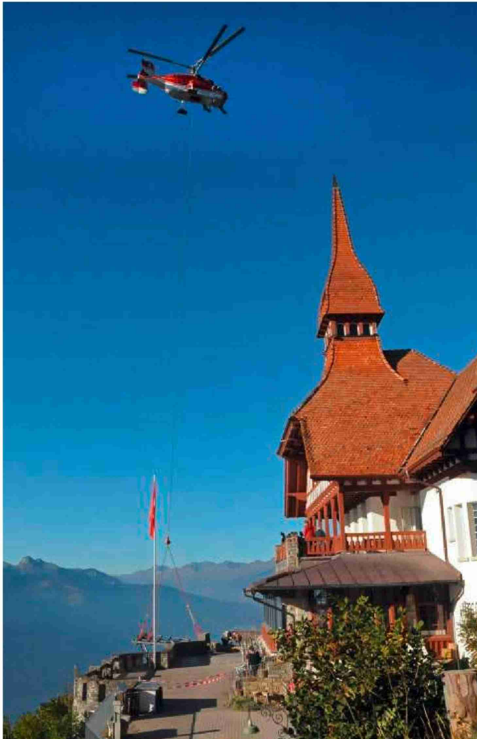
Der Schwerlast-Hubschrauber Kamov der Heliswiss setzt seine Last punktgenau auf die vorbereiteten Fundamente auf dem Harder Kulm ab.
