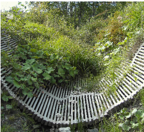
Erosionsschutz von Entwässerungsgräben mit flexiblen Holzrosten
