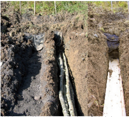
Ableiten von Hangwasser mit einem Steindrain, Stangendrain und Holzkännel
